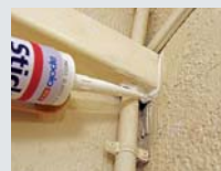
Dichtungen auf Beton
